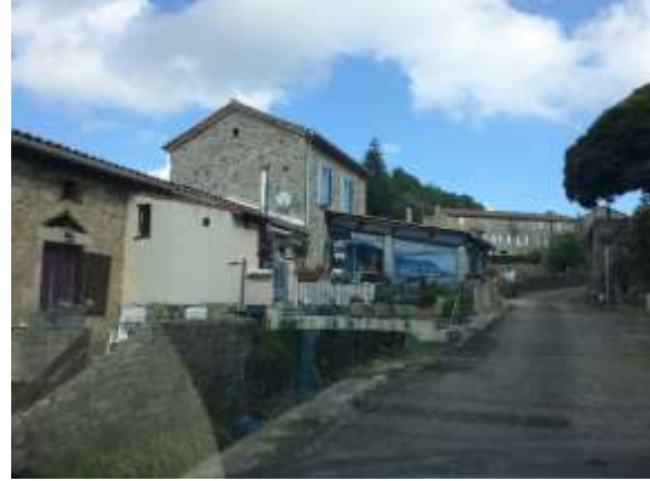
Les constructions résidentielles
